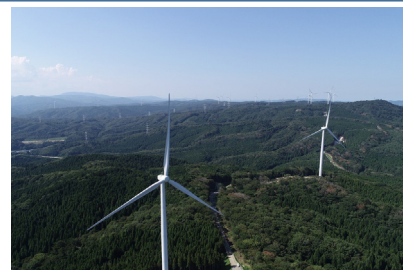
神楽山風力発電所 竣工写真 (いわき神楽山復興エネルギー合同会社)
