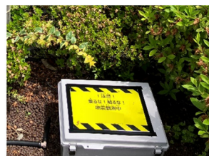
地表面への設置
