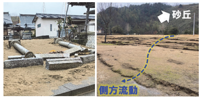
倒壊し、噴砂に覆われた鳥居
