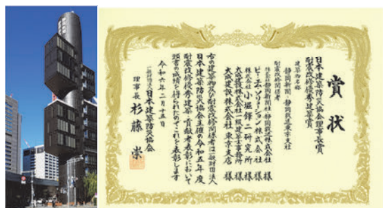
静岡新聞・静岡放送東京支社の全景と賞状
