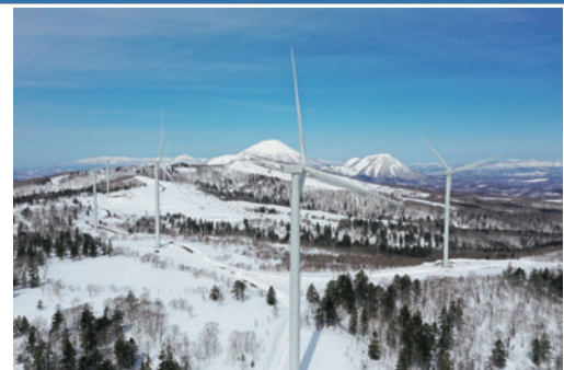
留寿都風力発電所 竣工写真
