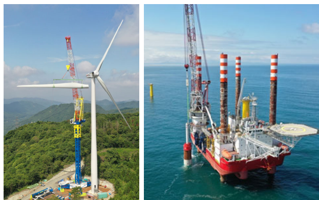
いちご米沢板谷ECO発電所 ブレード建設中の様子
