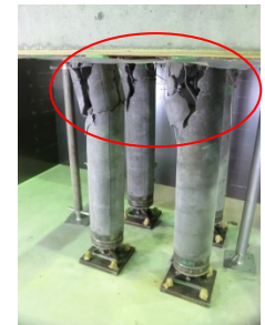
杭頭部分拡大 (全ての杭が杭頭破壊)
