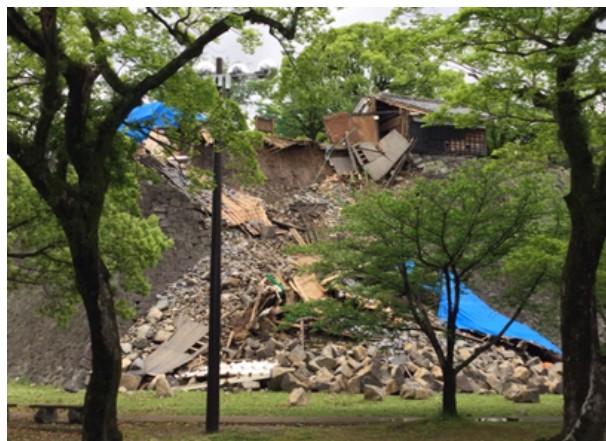
地震により崩れ落ちた熊本城の石垣と櫓
