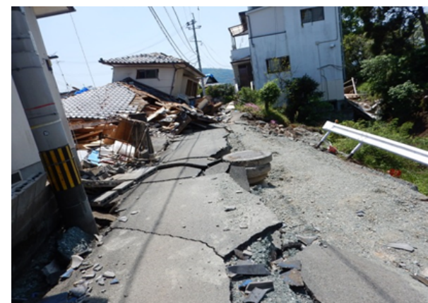
震度7(激震)を受けた益城町の住宅被害。耐震性に劣る古い住宅の倒壊や盛土の地盤変状など多くの被害状況を確認
