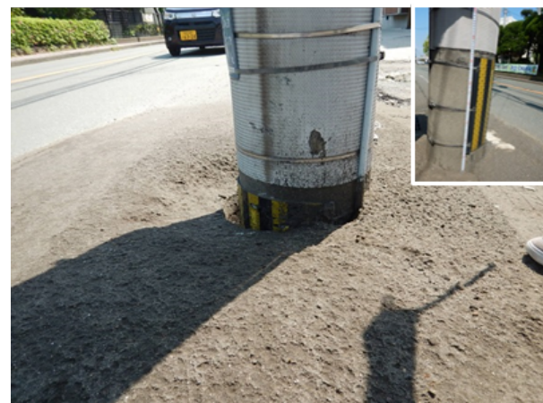
液状化により約60cm沈下した電柱。周辺には激しい噴砂の跡
