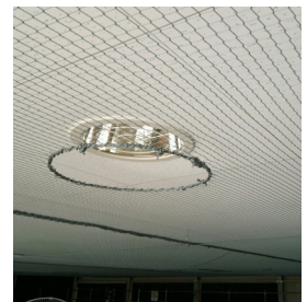
天井落下防止ネットの施工例
