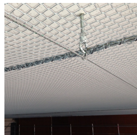
天井落下防止ネットの施工例
