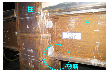
鉄骨造超高層建物の被害例
