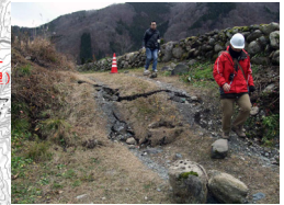
大出で認められた地表地震断層の様子
