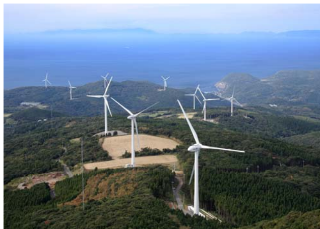
串木野れいめい風力発電所（2012年竣工）
