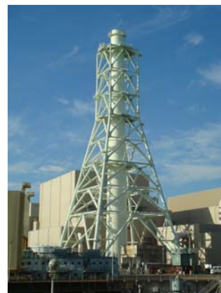
中電浜岡排気筒 Nu-DAM 適用施設
