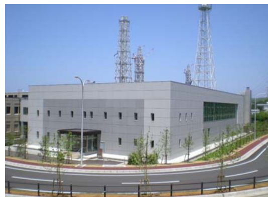
東京電力柏崎刈羽原子力発電所免震重要棟
