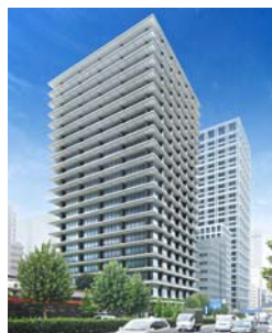
適用事務所建物 (赤坂センタービルディング)
