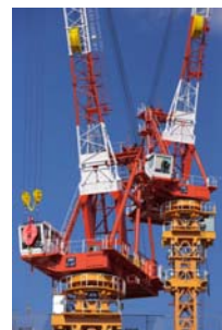
適用工事現場のタワークレーン (飯田橋西口地区再開発)
