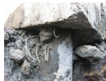
杭頭の損傷状況
