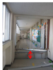
学校建物の沈下被害
